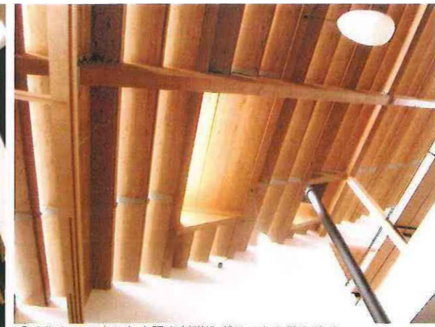
⑩木漏れ日のような太陽光が蹴込ガラスから降り注ぐ
