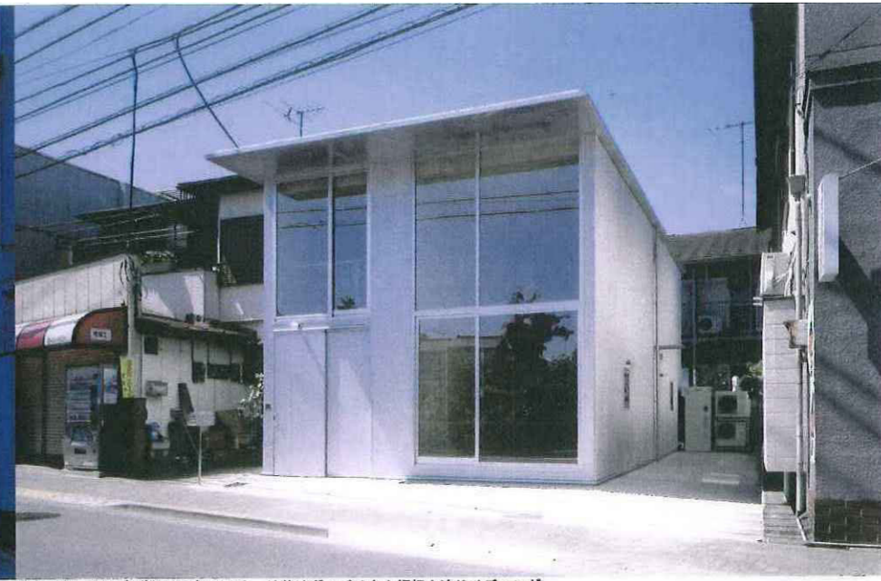
南側外観。深い庇が設けられている。外装はガルバリウム鋼板小波サイディング。
