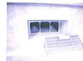
基礎換気口: 中間期から夏は開放
