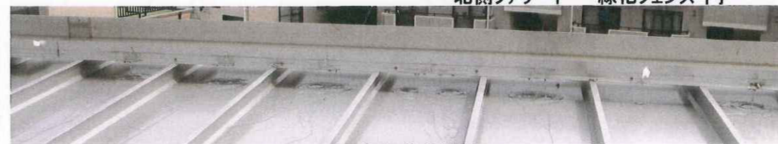
…屋根自動灌水装置… 夏季は一日に一回、屋根に井戸水を流し、その水が緑化フェンスにつたわる
