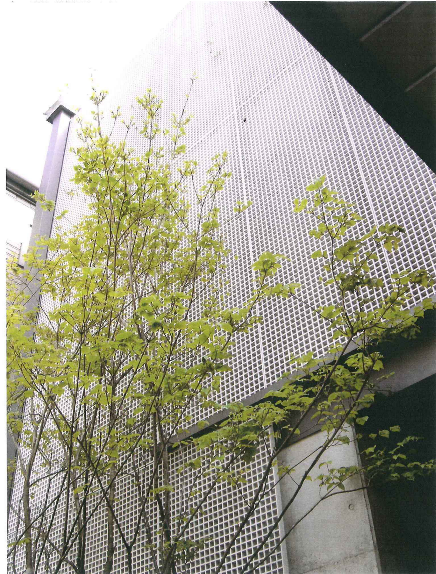
…北側ファサード シンボルツリー・緑化フェンス… 緑化フェンスで排気ガスを浄化し、商店街の喧騒から居住環境を守る
