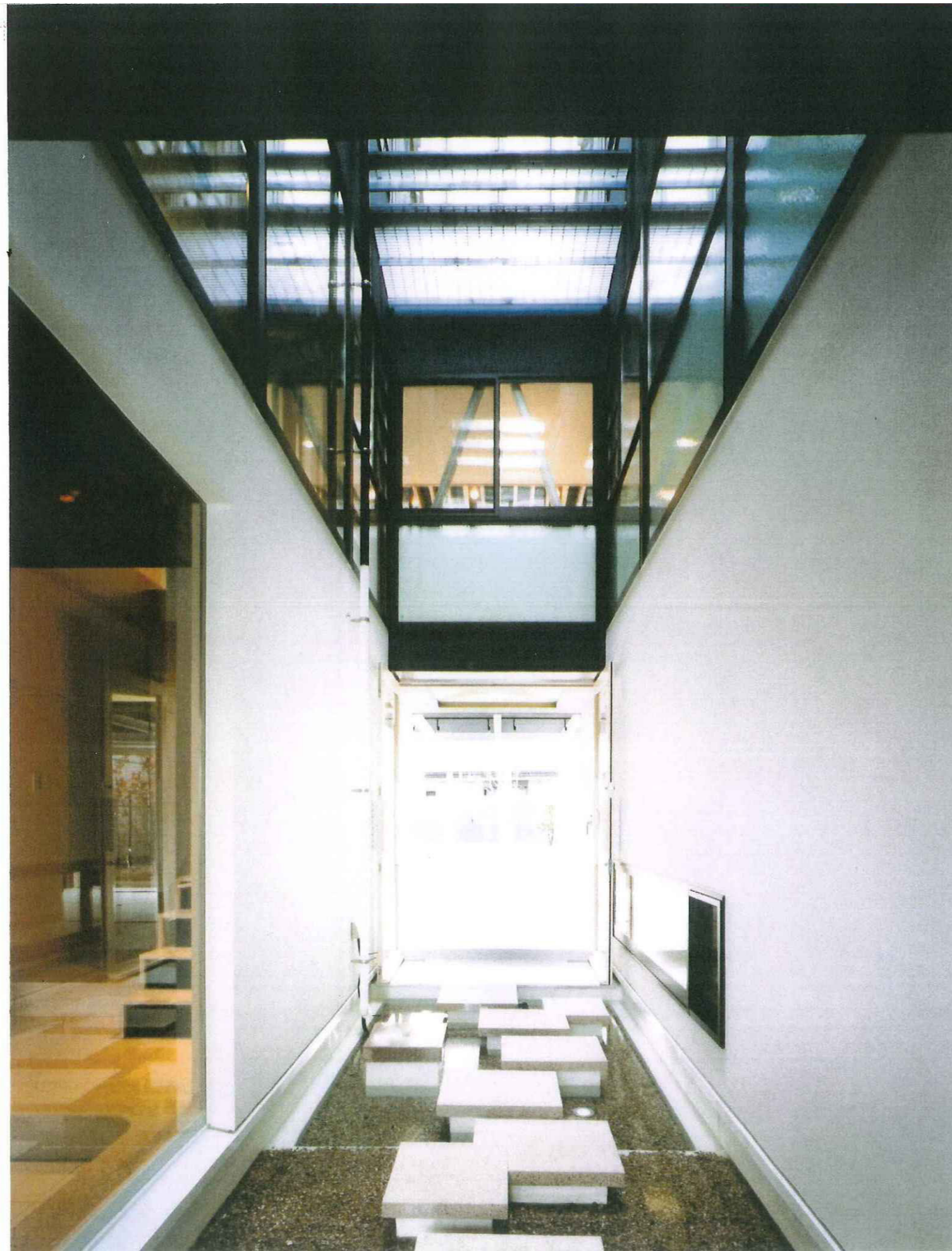
...パティオ 池=クールポンド...喧騒から静寂へ誘導。夏季は涼風を作り出す...
