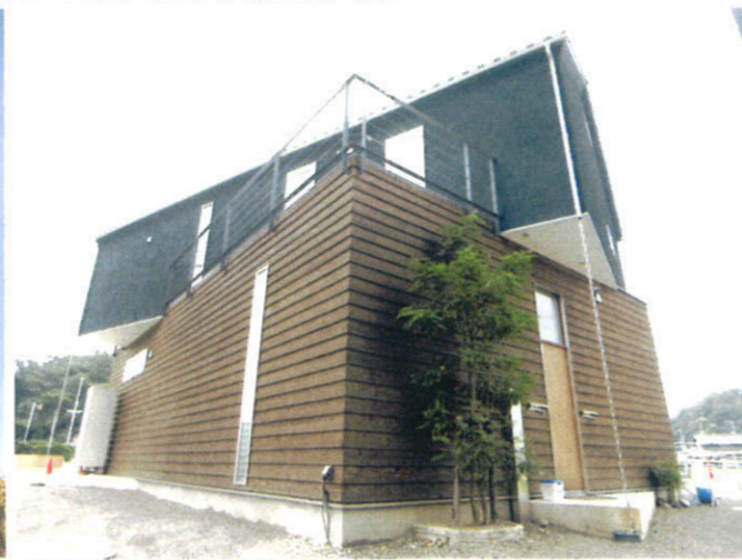
①外観全景：1・2Fをひねった形状で店舗に必要な視認性を持たせ、素材（焼杉といぶし瓦）で街並に溶け込む外観を形成
