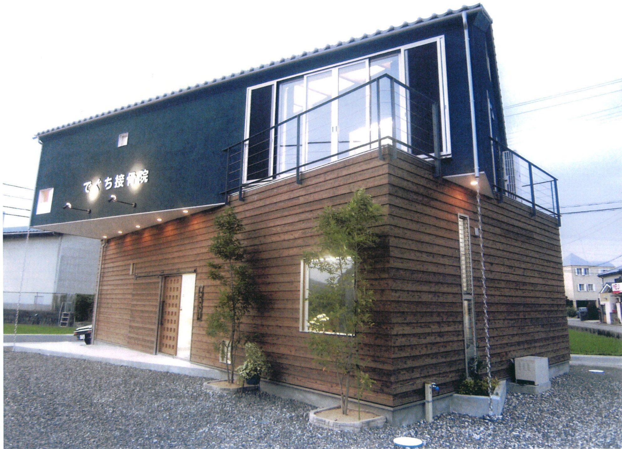
①外観全景：1・2Fをひねった形状で店舗に必要な視認性を持たせ、素材（焼杉といぶし瓦）で街並に溶け込む外観を形成
