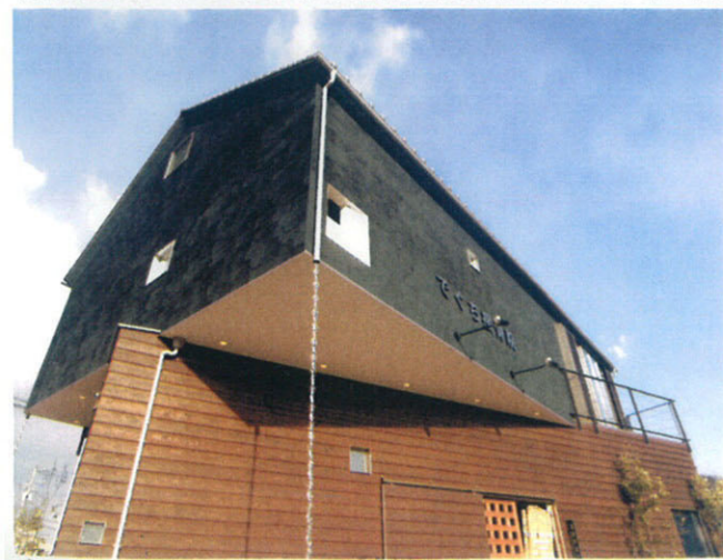
①外観全景：1・2Fをひねった形状で店舗に必要な視認性を持たせ、素材（焼杉といぶし瓦）で街並に溶け込む外観を形成
