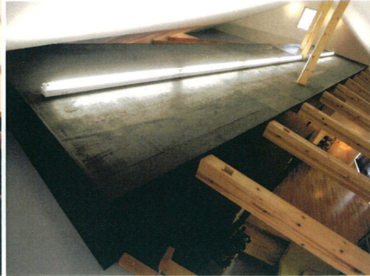
⑪ロフトから2Fを見下ろす：各室がロフト空間でつながり、1ルーム化することで、どの空間においても家族の気配を感じることができ、冷暖房費も節約する
