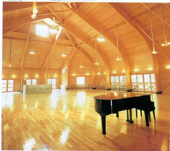
山梨県＝サニーデビレッジ・コンサートホール／設計＝井出一済建築設計事務所☎03(401)1531／施工＝斎藤木材工業☎0268(88)2525／床暖房施工＝山一冷凍設備☎0552(41)3308
