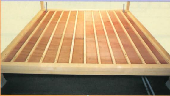
4 コンパネ取り付け作業完了。
