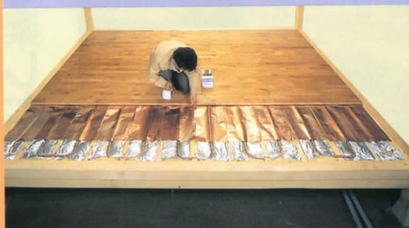
9 断熱材(グラスウール)敷き込み完了。
