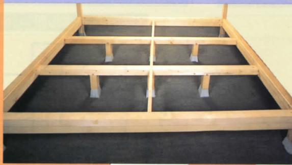
7 断熱材(スチロール)敷き込み完了。
